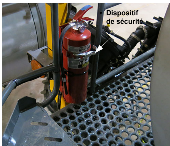
Extincteur d'incendie (situé le long de la plate-forme sur le côté gauche de la machine) - Vue typique
