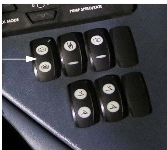
Commutateur de sélection des vannes des réservoirs (situé sur la console latérale) - Vue typique
