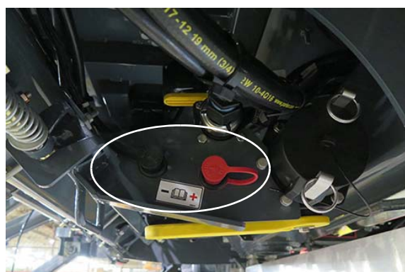
Prises électriques (à proximité du dispositif de remplissage par l'avant) - Vue typique
