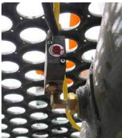
Управляющий клапан (возле ресивера) - стандартный вид
