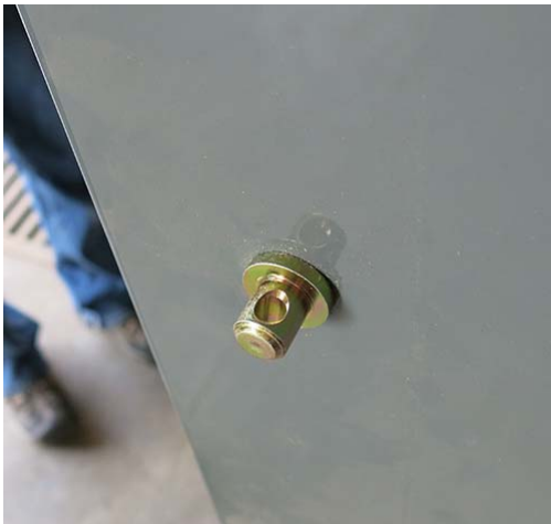
Függő csap elhelyezése – Tipikus nézet
