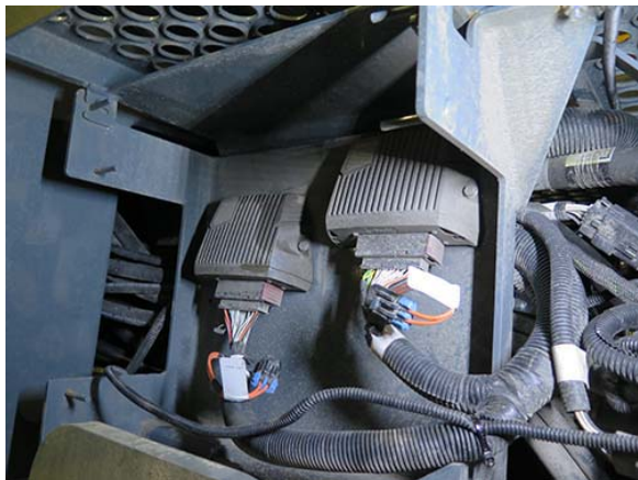
Hátsó érzékelő tápellátó biztosítékok (a gép alatt, a hátsó jobb kéz felőli kerék közelében) - Tipikus nézet
