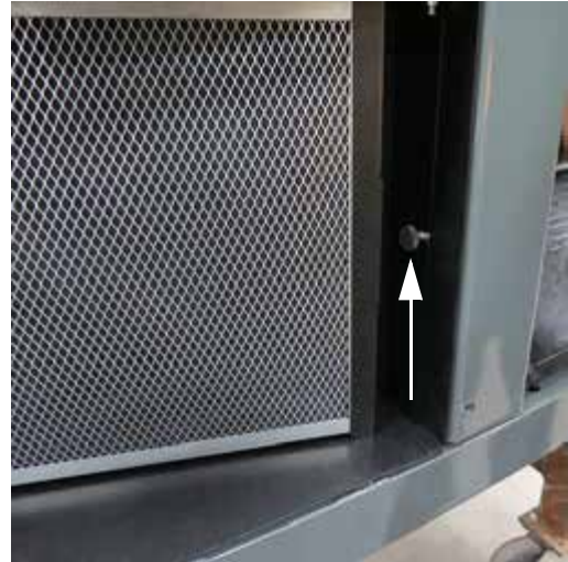
Tornillo de seguridad (ubicado por la parte interior del compartimento del filtro) -Vista típica
