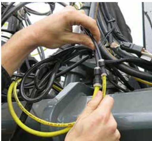
Conexión del marcador de espuma (situada en la parte delantera derecha de la máquina) -Vista típica
