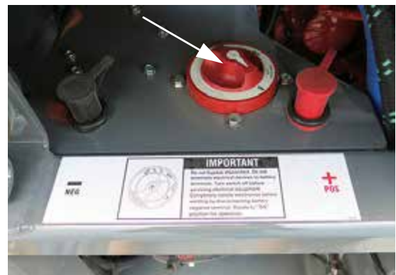
Interruptor de desconexión de la batería (ubicado en la parte posterior del chasis principal) -Vista típica
