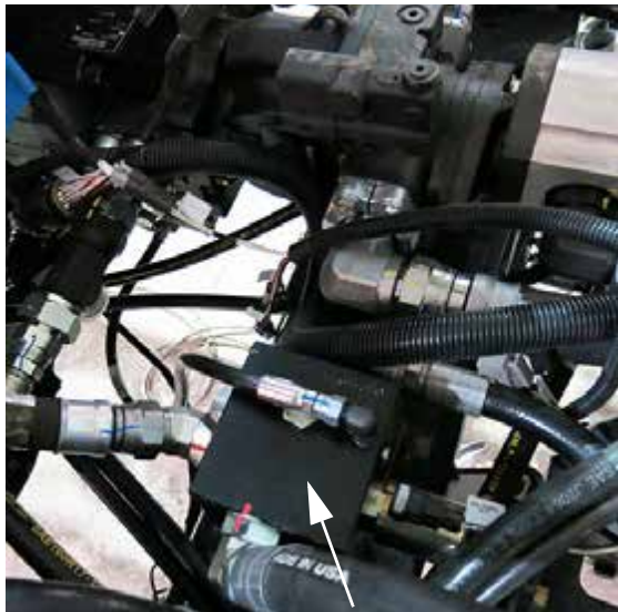
Colector de control de la bomba de solución (ubicado cerca del centro de la máquina) -Vista típica * Vista desde la parte superior de la máquina
