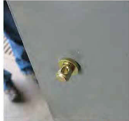
Függő csap elhelyezése – Tipikus nézet
