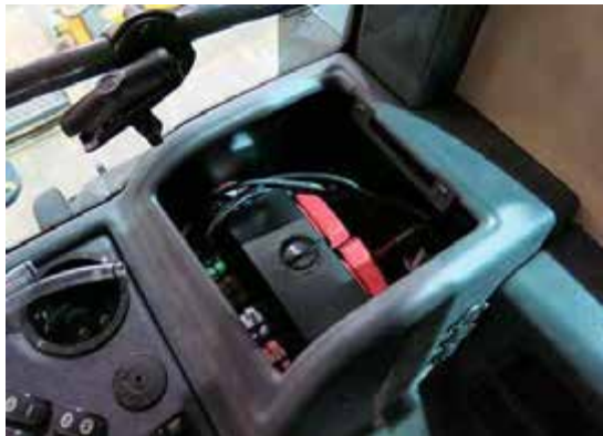
Megszakítók/biztosítékok (belül) (oldalsó vezérlőpult hátulján – a tálca levételével férhet hozzá) – Tipikus nézet
