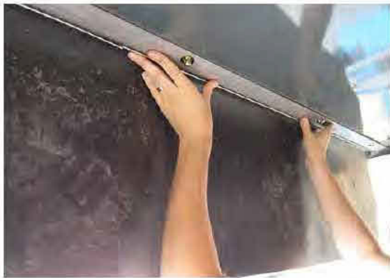
Súrolásvédelmi gumifüggöny telepítés – Tipikus nézet
