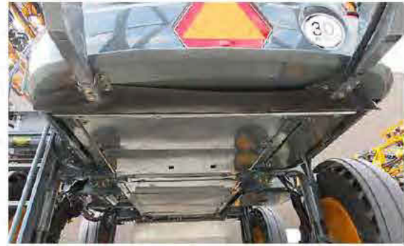
Alvázvédelmi szerelvény/súrlódásvédelmi gumifüggöny telepítés – Tipikus nézet
