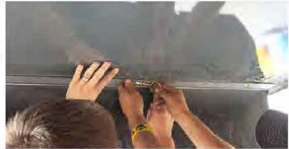
Biztonsági rögzítőcsap (a függő csapba elhelyezve) – Tipikus nézet
