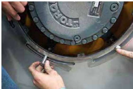
Kerék fedlemez szerelőcsavar telepítés – Tipikus nézet
