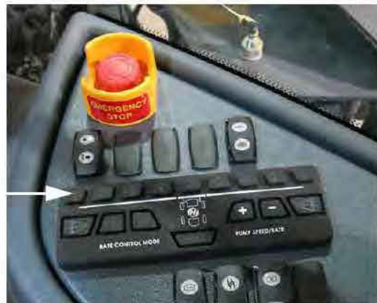
Gép permetlé szivattyú kapcsolók (oldalkonzolon) – Tipikus nézet
