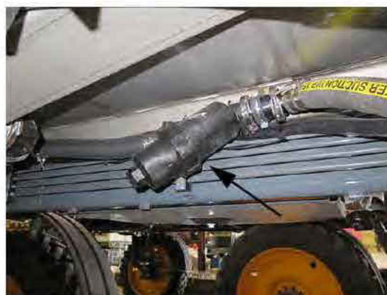
Crépine de la conduite de solution (située en dessous de la partie centrale du côté droit de la machine) - Vue typique
