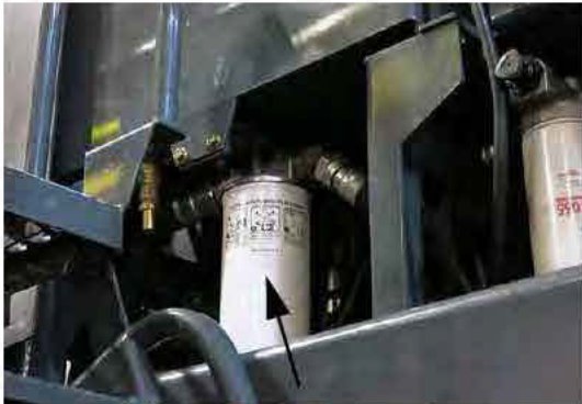
Filtere de retour au carter (situé sur le côté gauche de la machine) - Vue typique
