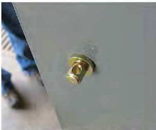
Installation des goupilles percées - Vue typique
