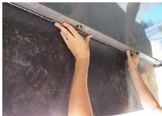
Установка щеточной шторки - стандартный вид
