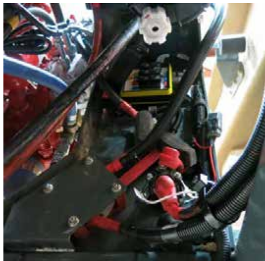
Блок предохранителей/реле конечного двигателя 4-го ряда (расположен под аккумуляторами с задней левой стороны машины) - Стандартный вид * Вид снизу машины
