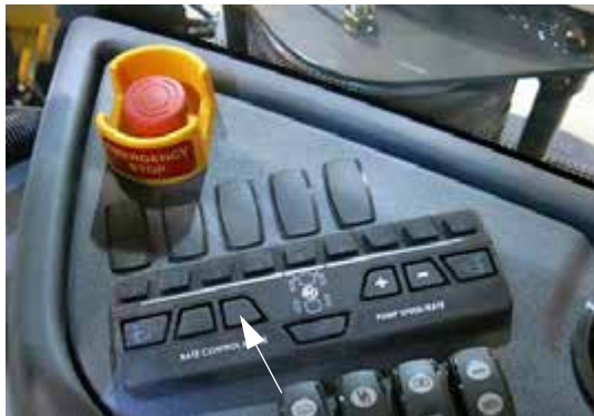
Interruptor manual (“MAN”) de control de tasa (ubicado en la consola lateral) -Vista típica
