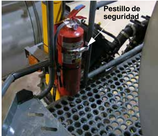
Extintor de incendios (ubicado junto a la pasarela en el lado izquierdo de la máquina) -Vista típica
