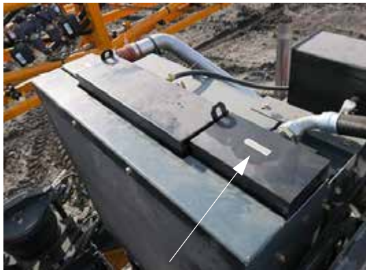
Refrigerador de aceite (ubicado cerca de la parte trasera de la máquina, abra el capó para tener acceso) -Vista típica
