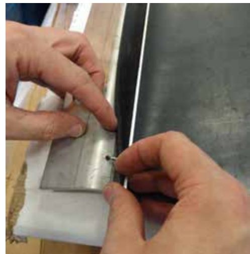
Súrolásvédelmi gumifüggöny szerelvény – Tipikus nézet
