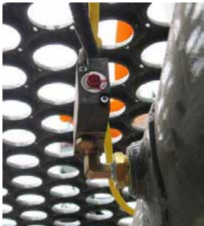
Управляющий клапан (возле ресивера) - стандартный вид
