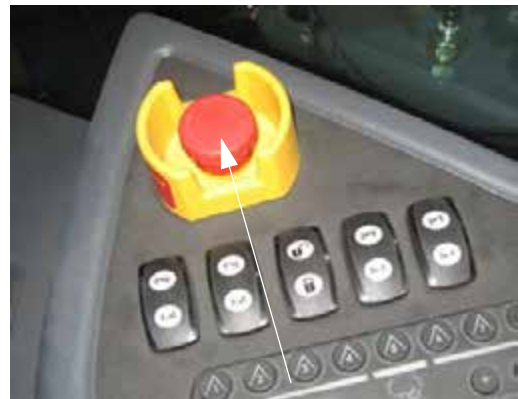
Interruptor E-Stop (ubicado en la consola lateral) -Vista típica
