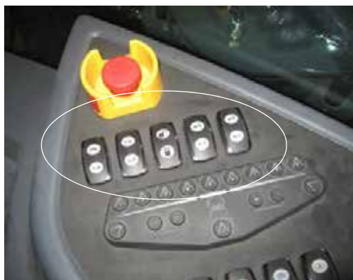
Interruptores del BHN de 60 pies (ubicados en el lado de la consola) -Vista típica
