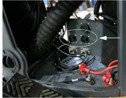
Puertos de diagnóstico Hagie (2) (ubicados en el interior de la consola lateral - retire el panel frontal para acceder) -Vista típica
