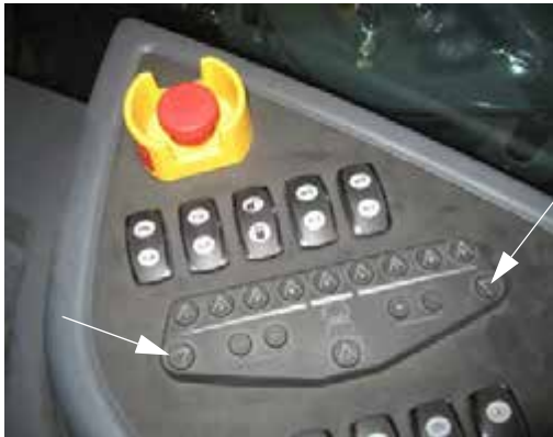
Kerítéssor kapcsolók (oldalsó vezérlőpulton) – Tipikus nézet
