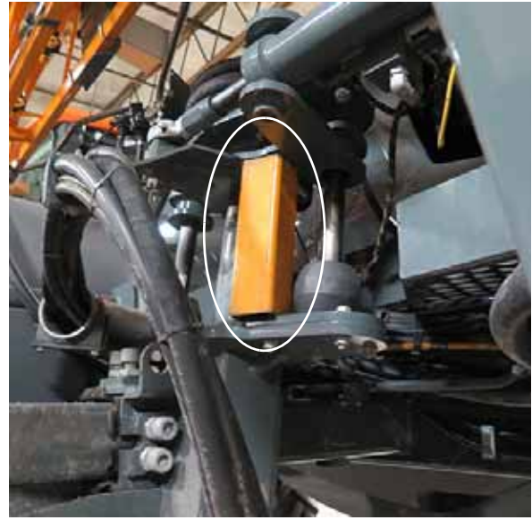
Tubo de acero instalado debajo de la placa de soporte de la bolsa de aire - Vista típica
