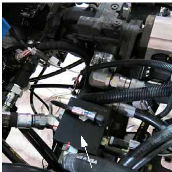
Colector de control de la bomba de solución (ubicado cerca del centro de la máquina) -Vista típica
