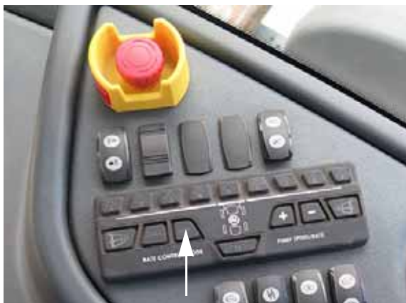
El interruptor de control de tasa "MAN" (ubicado en la consola lateral) -Vista típica
