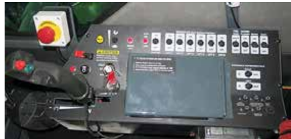
Accesul la siguranța circuitului (sub consola laterală - scoateți maneta de comandă a transmisiei hidrostatice și șuruburile panoului superior pentru acces) - Vedere tipică
