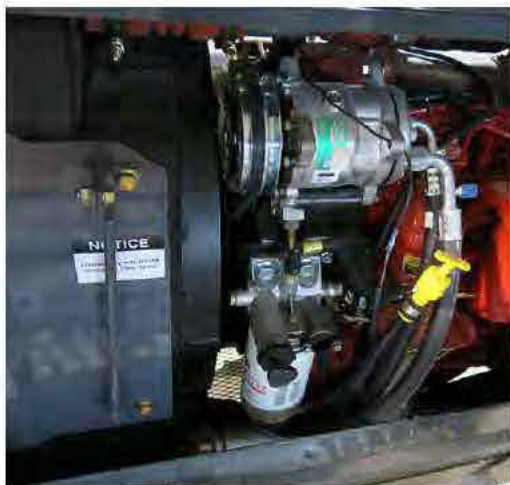
Porta de carga do A/C (Localizado no lado esquerdo da máquina - capota aberta para acesso) -Vista típica
