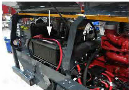
Acesso à bateria
