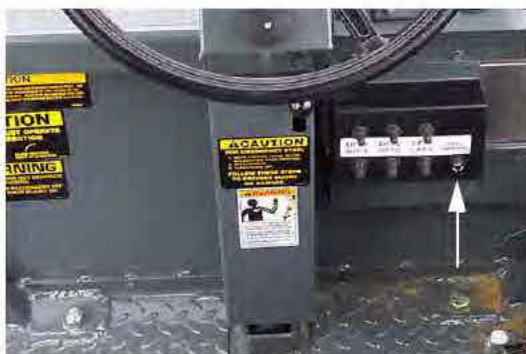
Fusível do comando de profundidade (Localizado no painel da chave do comando de profundidade, perto da dianteira da estação do operador) -Vista típica
