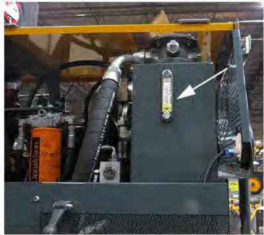
Medidor com visor do reservatório de óleo hidráulico (localizado no reservatório de óleo hidráulico) -Vista típica
