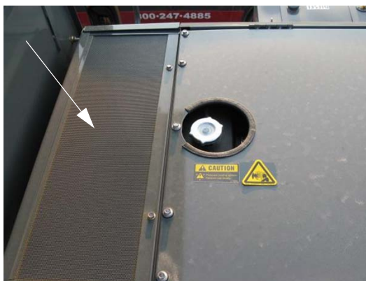
顶部栅屏 (拆除两个散热器面板螺栓 和面板后, 可以够着) - 典型视图
