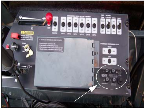
Siguranțele (Aflate pe consola laterală) –Vedere tipică
